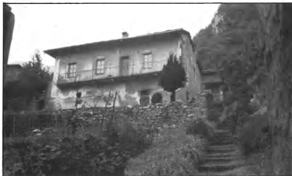
Fig. 4. Villar Focchiardo. Priorato del Sacro Cuore di Maria. Particolare del fabbricato.
