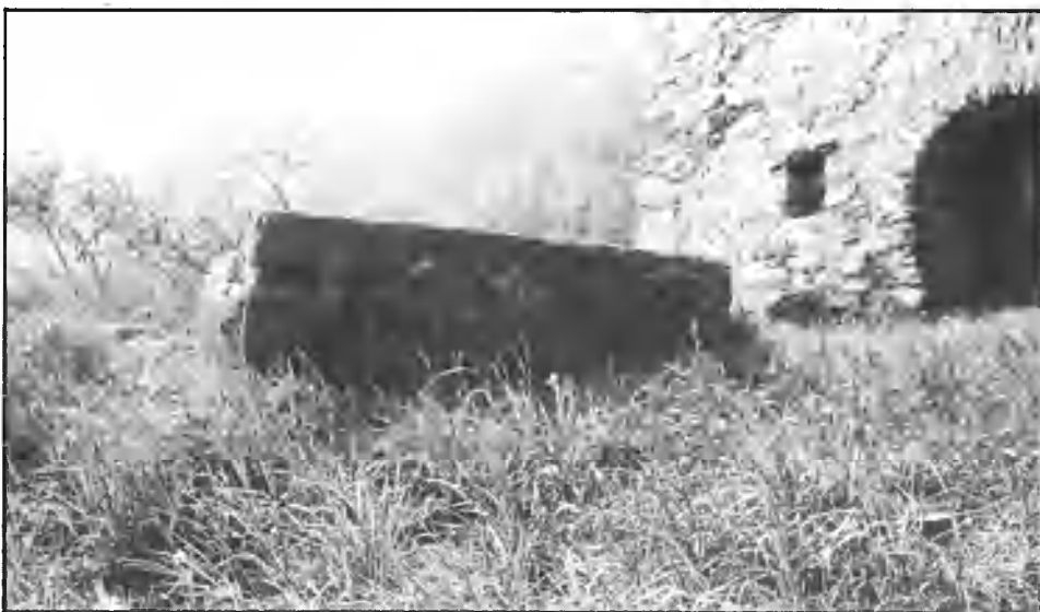
Da scheda micro TP: Terrazza (Exilles). Fontana a terrazza ovest. La vasca interrata è formata da 4 lastroni in pietra, giunti imperfettamente da ferri, di cui uno conserva la data 1583, le iniziali RB ed il giglio del Delfinato.
