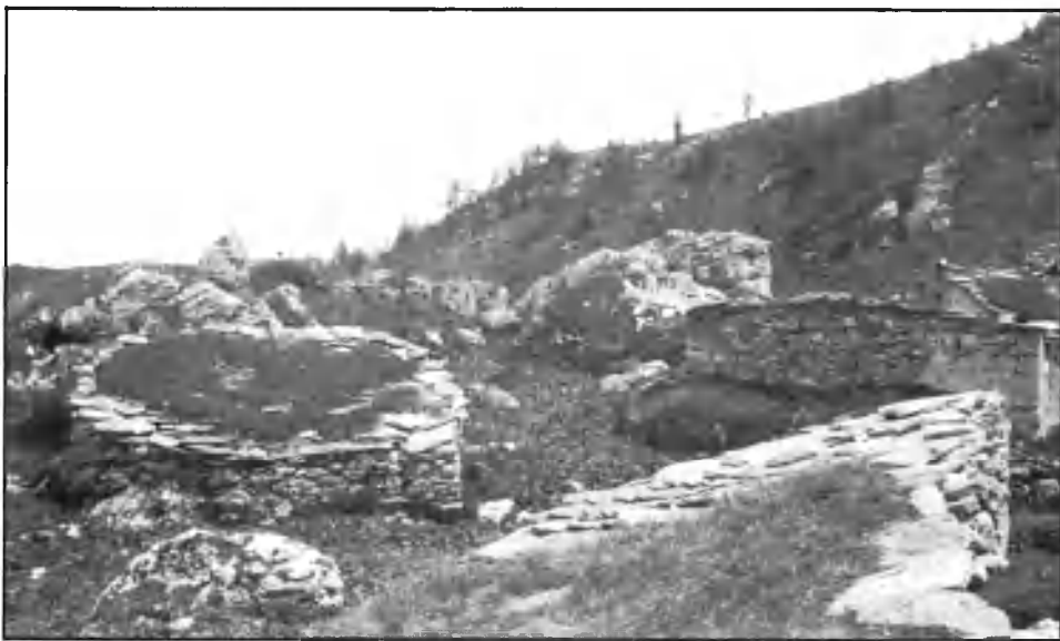
Da scheda TP: Thuille (Exilles). Tipo edilizio: casa del pascolo. Il modulo è rettangolare o quadrato, parzialmente scavato nel terreno, l'elissoide è più antico.
