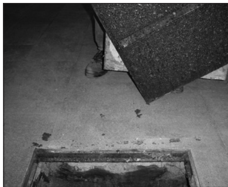
Figura 3. Botola di accesso (foto Minaldi).
