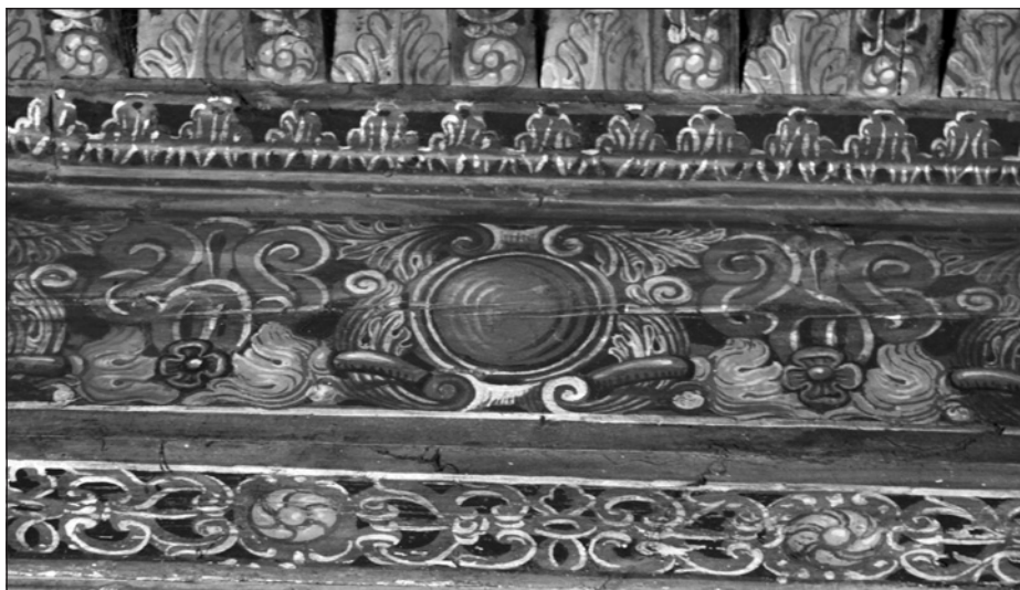
Decorazioni sul soffitto ligneo.
