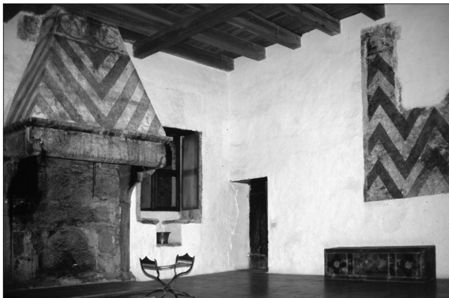
La sala Nord del Primo Piano. Si possono notare le tracce della decorazione a fasce bianche e rosse ad andamento spezzato, che ricoprivano tutte le pareti della stanza. Al contrario della decorazione, il mobilio del Milleduecento era molte semplice.
