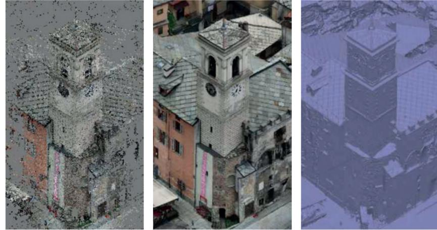
Fig. F1 - Nuvola di punti rada (tie-points) dei resti della Porta Piemonte di Susa e dell'area ad essa limitrofa, estratta tramite processo fotogrammetrico.
